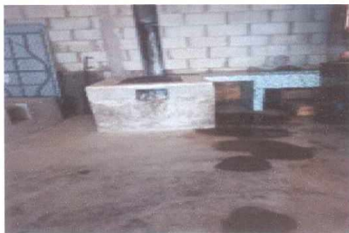
Foto 5: Cambio de piso en la cocina
