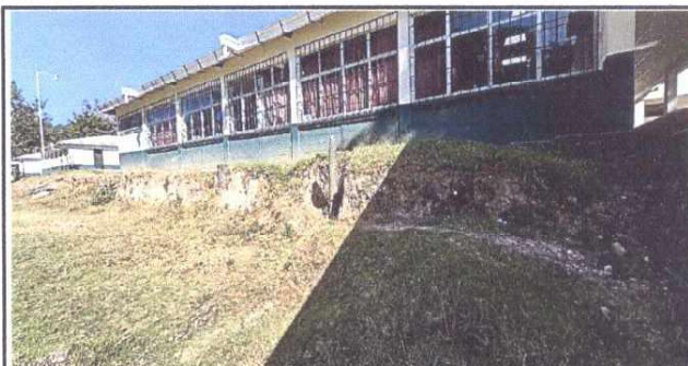
Foto 4: Completar muro perimetral
