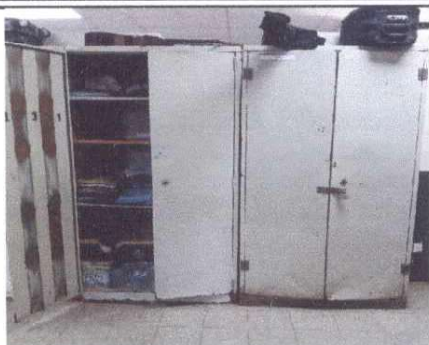
Foto 1: Puertas de los lockers se encuentran en mal estado
