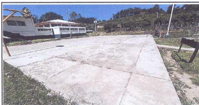
Foto 3: El alumbrado del exterior se encuentran en mal estado
