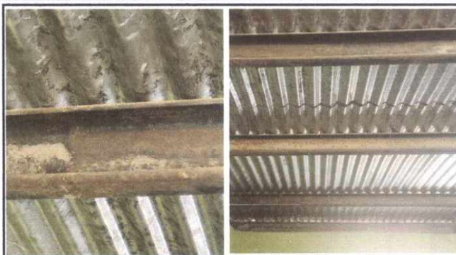
Foto 2: ESTRUCTURA DE TECHO
