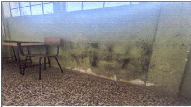
Foto 4: PINTURA EN MUROS EXTERIORES E INTERIORES
