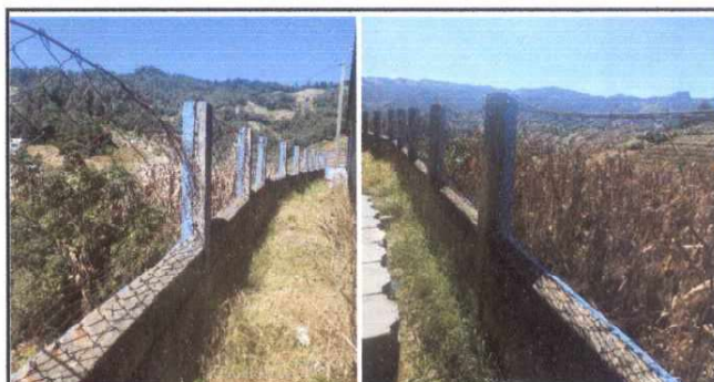
Foto 6: MANTENIMIENTO A BARANDAS
