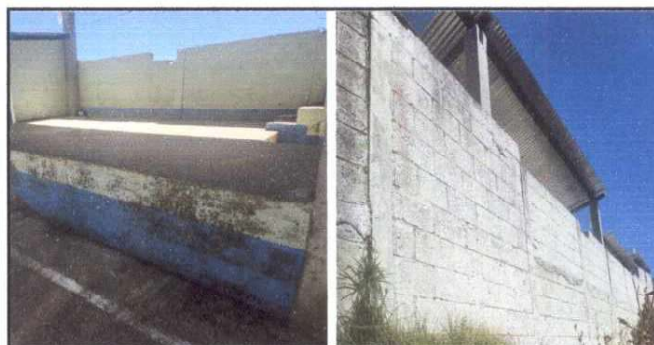
Foto 5: PINTURA EN MUROS EXTERIORES E INTERIORES
