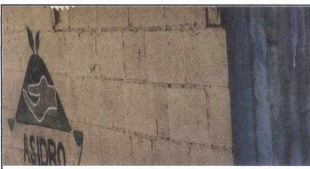
FOTO 2: Mejoramiento de paredes
