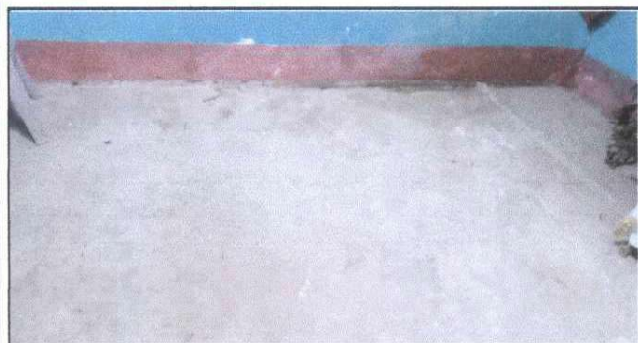
FOTO 1: Reparación del piso
