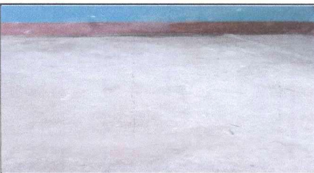
FOTO 2: Mejoramiento de piso
