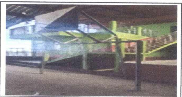
Foto 5: La colocación del tablero en frente del escenario
