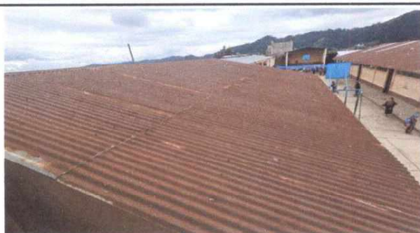
Foto 5: LAMINAS RAJADAS, NECESITA CAMBIO
