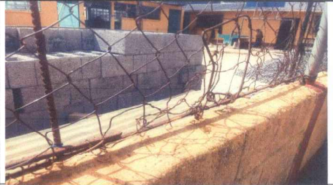
Foto 2: Continuación de la reparación del muro para la comunidad educativa
