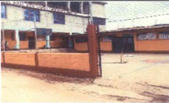
Foto 3: Cambio de porton en mal estado
