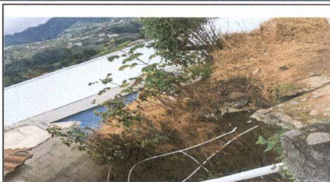
Foto 2: REMODELACIÓN DE MURO
