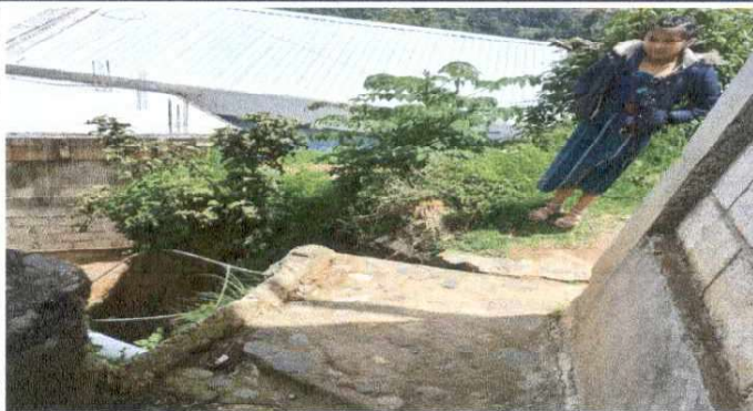
Foto1: REMODELACIÓN DE MURO
