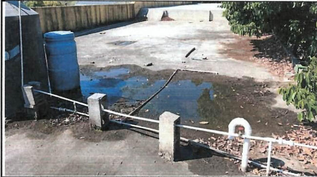
Foto 1: LIMPIEZA TOTAL, COLOCACION DE PAÑUELOS, IMPERNIABILIZANTE A ESTA PARTE DE LA TERRAZA Y CAMBIO DEL SISTEMA DE TUBERIA
