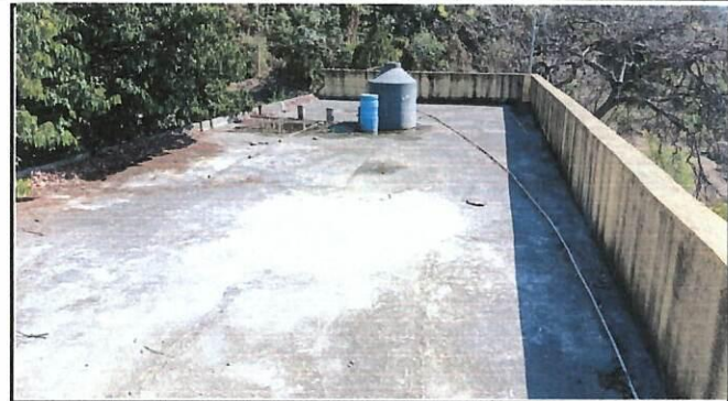
Foto 2: LIMPIEZA TOTAL, COLOCACION DE PAÑUELOS Y IMPERNIABILIZANTE A ESTA PARTE DE LA TERRAZA
