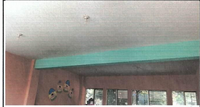
Foto 4: CAMBIO DE LUCES A LUCES LED DEL GRADO DE TERCERO PRIMARIA
