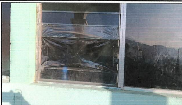
Foto 2: CAMBIO DE VIDRIOS DEL GRADO DE TERCERO PRIMARIA
