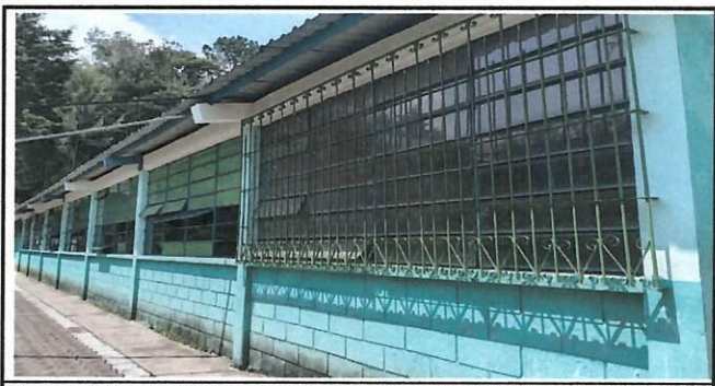
Foto 5: Instalacion de balcones en ventanas de cocina y comedor de 3.64*1.85 con dos manos de pintura anticorrosiva color verde
