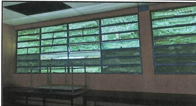
Foto1: Instalacion de ventanas corredizas serie 88 con vidrio reflectivo bronce de 5mm. En comedor de 3.47*1.73 dividida 50 cm fijo con estructura de aluminio y 1.23 corredisa con mosquitero serie 60 reforzada con metal.
