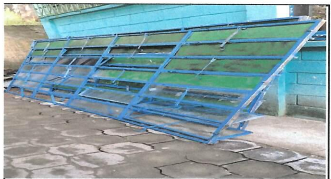
Foto 4: desontaje de ventanales de cocina y comedor
