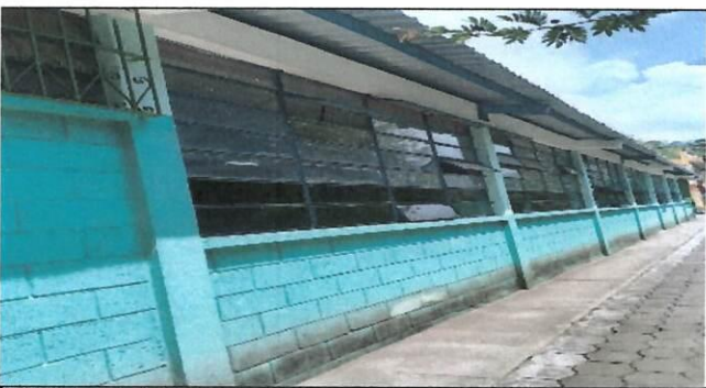
Foto 6: Instalacion de balcones en ventanas de cocina y comedor de 3.64*1.85 con dos manos de pintura anticorrosiva color verde
