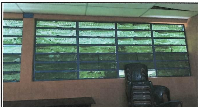
Foto3: Instalacion de ventanas corredizas serie 88 con vidrio reflectivo bronce de 5mm. En cocina de 3.47*1.73 dividida 50 cm fijo con estructura de aluminio y 1.23 corredisa con mosquitero serie 60 reforzada con metal.
