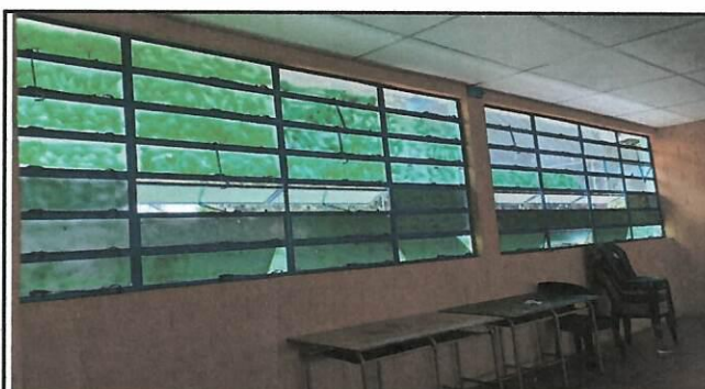
Foto4: Instalacion de ventanas corredizas serie 88 con vidrio reflectivo bronce de 5mm. En cocina de 3.47*1.73 dividida 50 cm fijo con estructura de aluminio y 1.23 corredisa con mosquitero serie 60 reforzada con metal.
