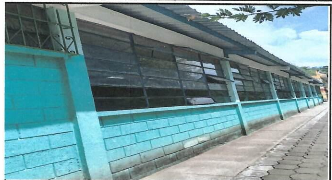
Foto 2: Instalacion de balcones en ventanas de cocina y comedor de 3.64*1.85 con dos manos de pintura anticorrosiva color verde
