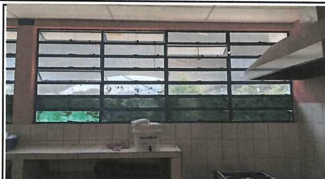
Foto2: Instalacion de ventanas corredizas serie 88 con vidrio reflectivo bronce de 5mm. En cocina de 3.47*1.73 dividida 50 cm fijo con estructura de aluminio y 1.23 corredisa con mosquitero serie 60 reforzada con metal.
