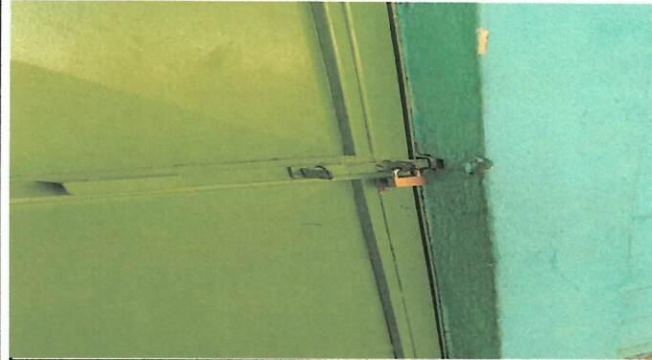
Foto 1: suministro e instalacion de chapas en puerta de comedor
