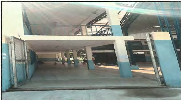
Foto1: Estructura para cambio de puerta y techado para la entrada de la escuela.
