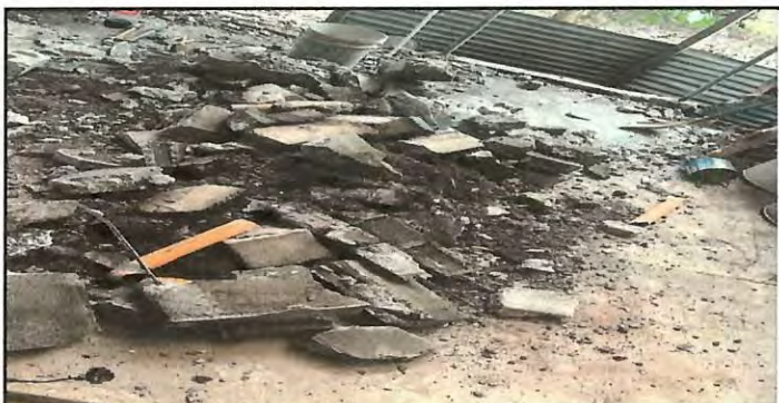
Foto 6: Relleno con material selecto
