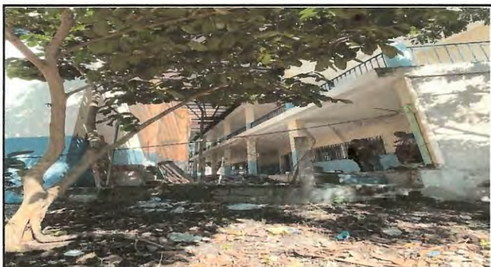
Foto 4: Levantamiento de muro perimetral.
