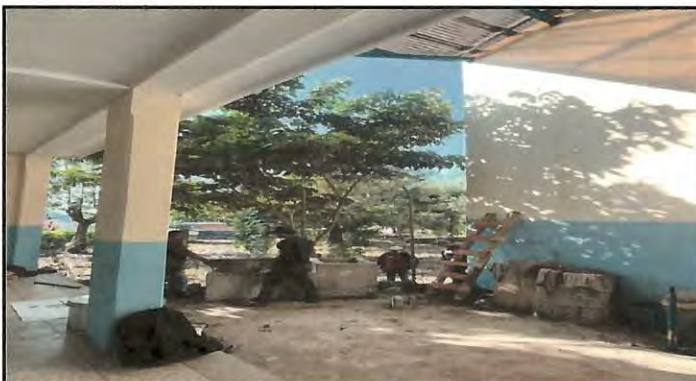
Foto 3: Colocación de pilas y lavamanos.
