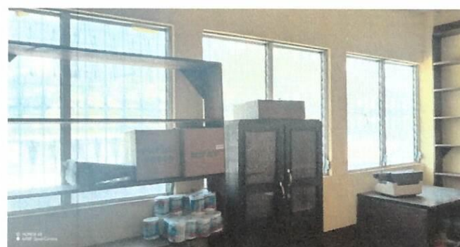
Foto 4: Desinstalación de ventanas he instalación de ventanas corredizas de pvc con mosquitero
