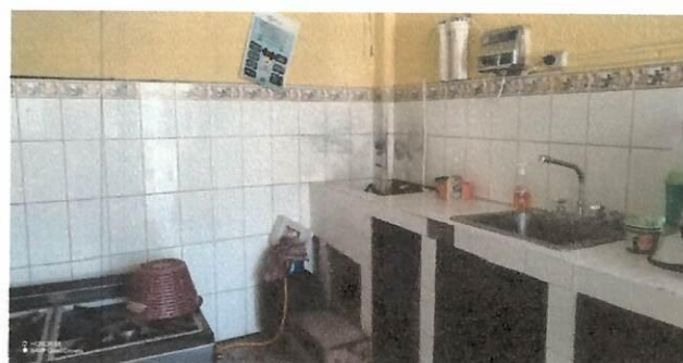
Foto 2: Demolición de lavatrastos para construcción de un lavatrastos para ollas grandes
