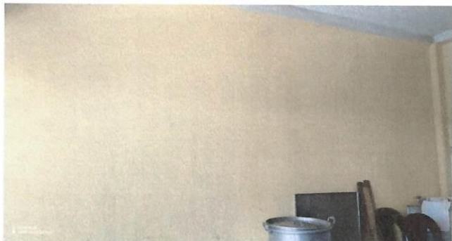
Foto 1: Demolición de muro para tener acceso a cocina mas amplia con la bodega
