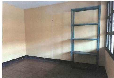
Foto 4: Remoción de division de tablayeso ubicado al lado izquierdo de la fotografía, instalación de dos gabinetes aéreo y terrestres.
