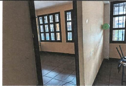
Foto 2: Remoción de divisiones de tablayeso y cambio de ventanas agregando mosquitero.
