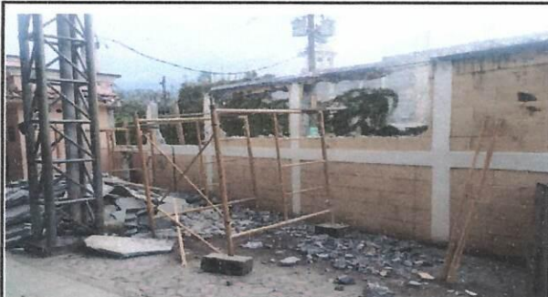
Foto 5: INICIO DE DEMOLICION DE MURO
