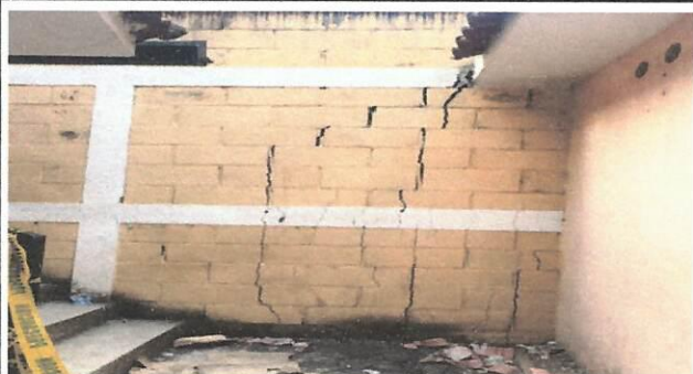
Foto 1: REPARACIÓN DE MURO PERIMETRAL
