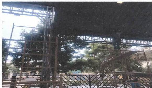
Foto 4: INICIO DE CAMBIO DE CABLEADO EN TECHO DE CANCHA
