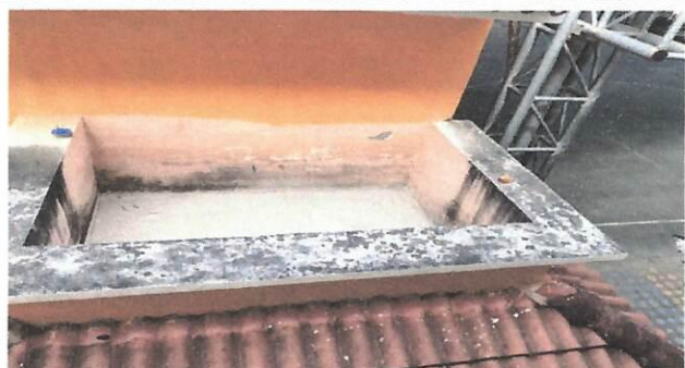
Foto 3: LIMPIEZA Y CAMBIO DE PAÑUELOS SOBRESANITARIOS
