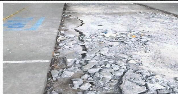
Foto 6: INICIO DE LAVANTAMIENTO DE PAVIMENTO
