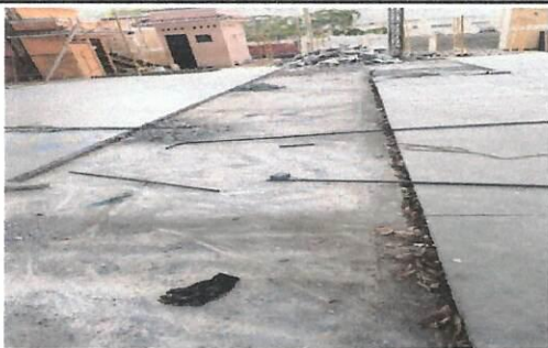
Foto 5: INICIO DE LAVANTAMIENTO DE PAVIMENTO
