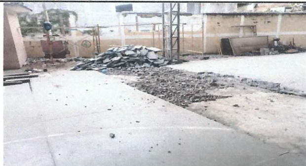
Foto 1: INICIO DE LAVANTAMIENTO DE PAVIMENTO
