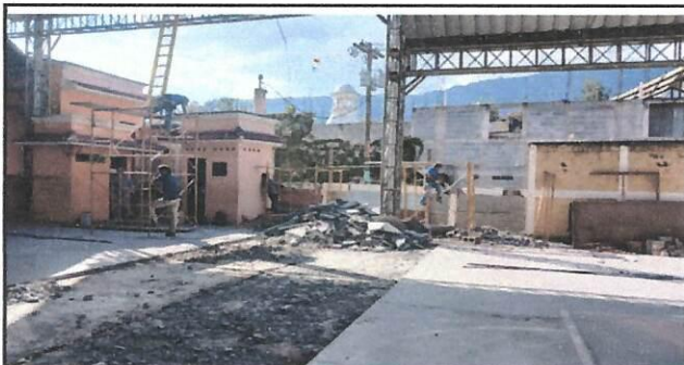
Foto 3: INICIO DE LAVANTAMIENTO DE PAVIMENTO
