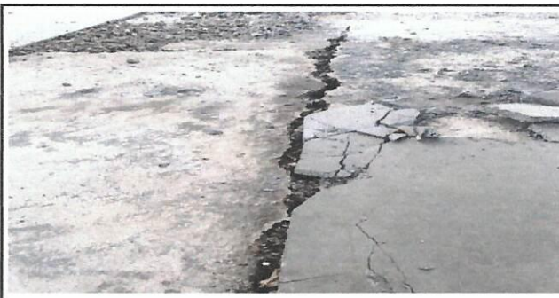
Foto 4: REVISIÓN DE FALLA
