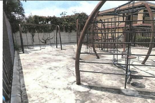
Foto 2: Instalación de canal para retener el agua pluvial, sobre la cerca metálica ubicada del lado izquierdo de la fotografía.
