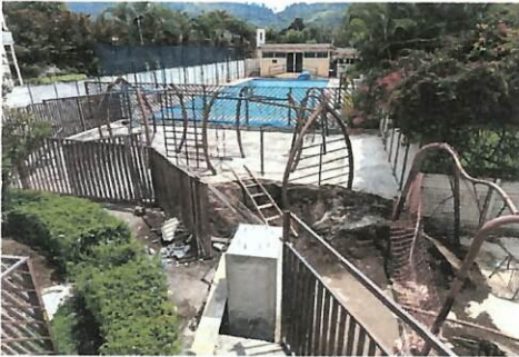
Foto 1: Instalación de techo de dos aguas sobre el área de juegos ubicado al fondo la fotografía del lado derecho
