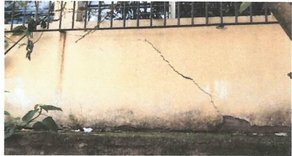
Foto 2: Reparación de paredes de exterior que da en el lado de graderío de escuela preprimaria
