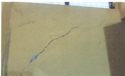
Foto 5: grietas de las paredes de los sanitarios de señóritas
