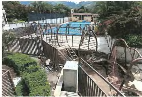
Foto 3: El área a remodelar es el que se observa del lado izquierdo.
