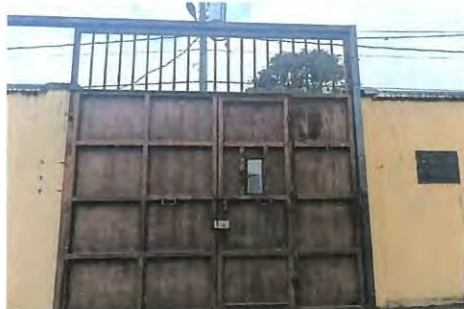
Foto 3: División del portón en dos paneles, chapa eléctrica y pintura en general.
