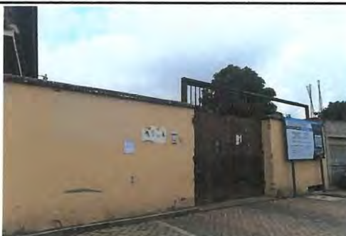
Foto 5: Ampliación de 50 centímetros de altura.
