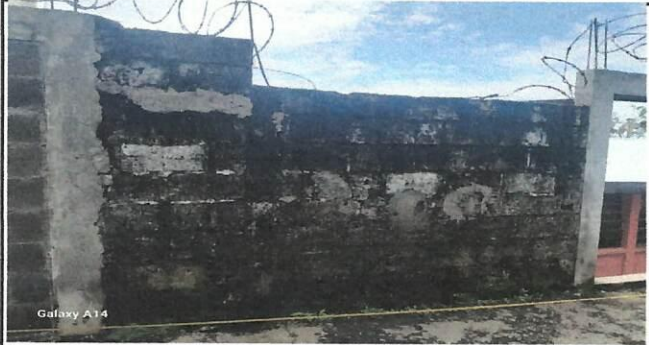
Foto 1: Muro perimetral de la parte de atrás.
