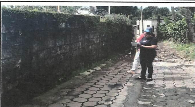
Foto 2: Muro perimetral de la parte de atrás, lado izquierdo.
