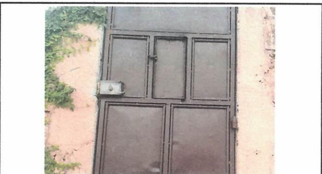
Foto 4: Cambio de puerta en muro perimetral, para acceso a salida.
