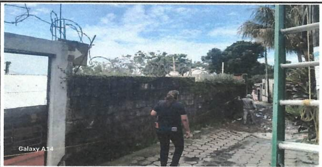
Foto 5: Muro perimetral de la parte de atrás.
