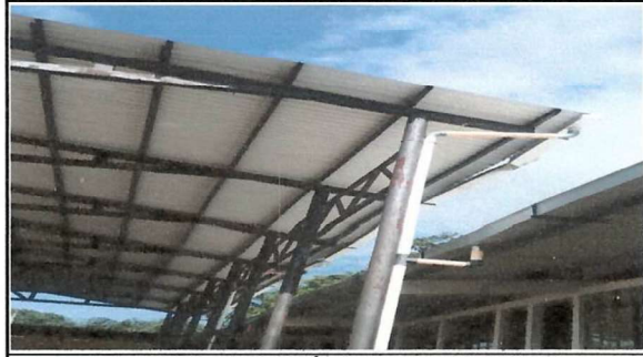
Foto 8: SUMINISTRO Y FABRICACIÓN DE 70 METROS DE CANAL
