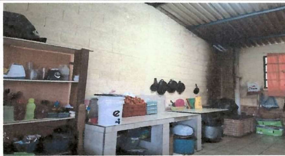
Foto1: SUMINIS. Y COLOC. 50 MET. AZULEJO INTERIOR COCINA
