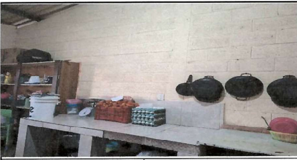
Foto 5: SUMINISTRO Y FABRICACIÓN DE GABINETE AEREO EN COCINA
