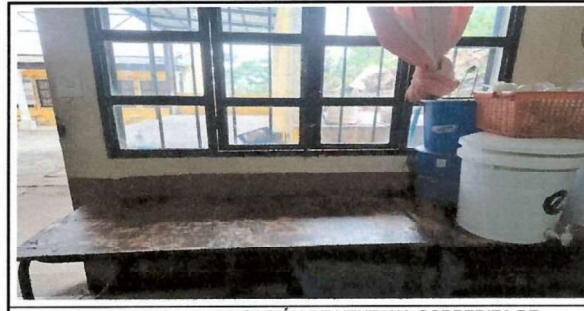
Foto 6: SUMINISTRO Y FABRICACIÓN DE VENTANA CORREDIZA DE COCINA
