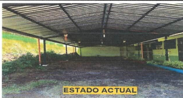
Foto 5: Estado actual del proyecto.
