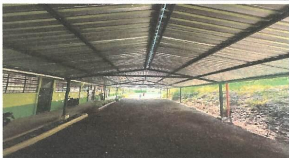
Foto 1: Eliminación de tierra.
