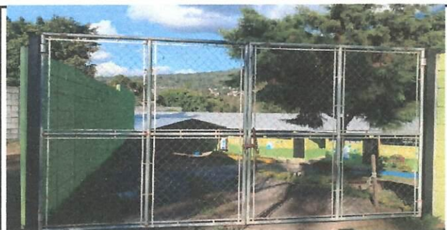
Foto 5: Sustitución de la malla por porton.
