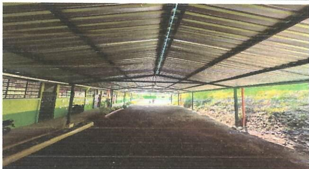
Foto1: Eliminacion de tierra.
