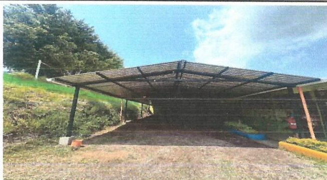
Foto 2: Nivelacion del terreno e implementacion de gramiila artificial.
