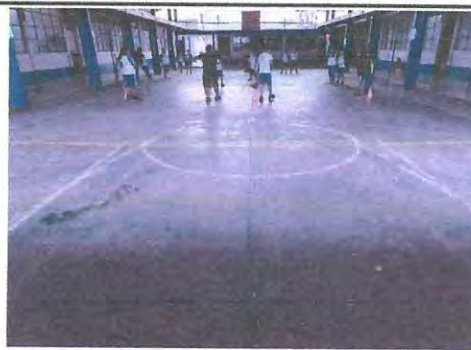
Foto 22: MEJORAMIENTO DE ÁREA DEPORTIVA
