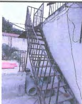
Foto 23: Mantenimiento de baranda
