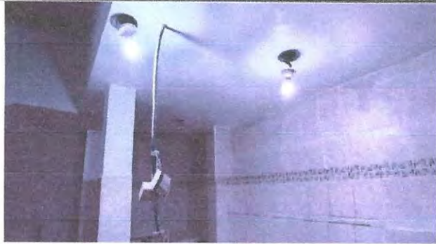
Foto 7: MEJORAMIENTO DE SISTEMA ELECTRICO COCINA.
