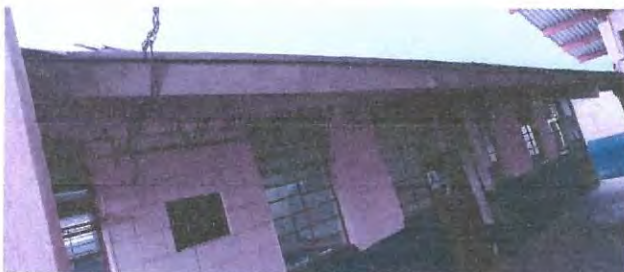
Foto 11: SUSTITUCIÓN DE CANALES.
