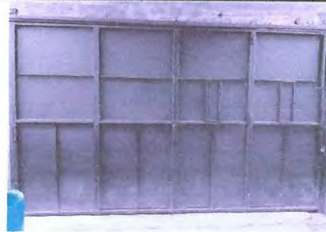
Foto 18: CORRECCIÓN Y MEJORAMIENTO DE PORTÓN
