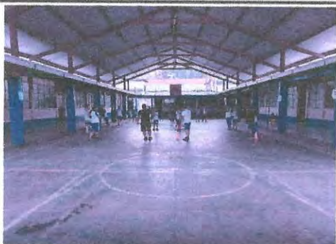
Foto 3: PINTURA INTERIOR ESCUELA
