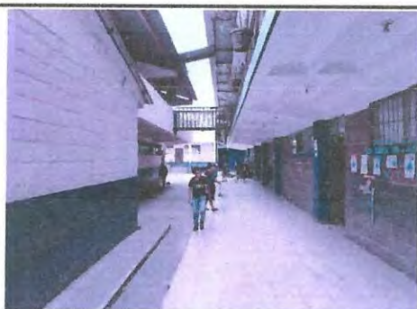
Foto 5: PINTURA INTERIOR ESCUELA
