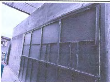
Foto 17: CORRECCIÓN Y MEJORAMIENTO DE PORTÓN
