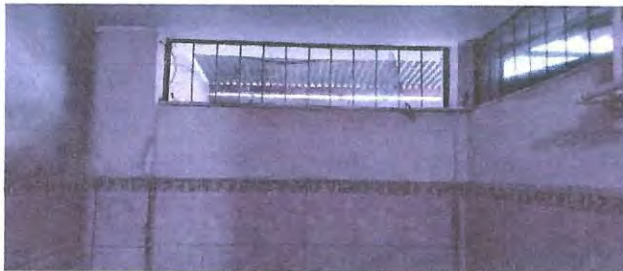
Foto 9: MEJORAMIENTO VENTILACIÓN COCINA. VENTANA
