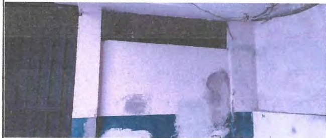
Foto 10: MEJORAMIENTO VENTILACIÓN COCINA. VENTANA.
