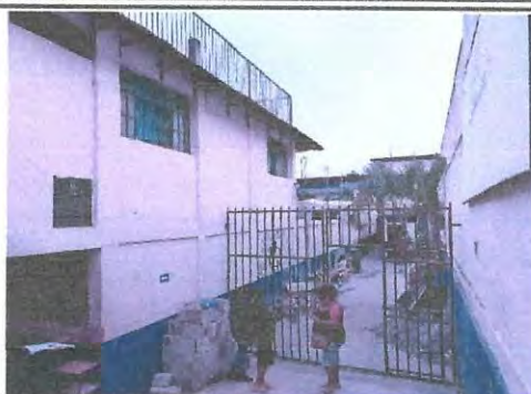
Foto 2: PINTURA INTERIOR ESCUELA
