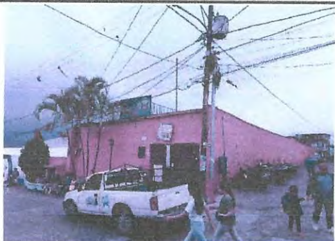
Foto1: PINTURA EXTERIOR ESCUELA.
