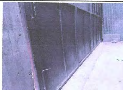
Foto 16: CORRECCIÓN Y MEJORAMIENTO DE PORTÓN
