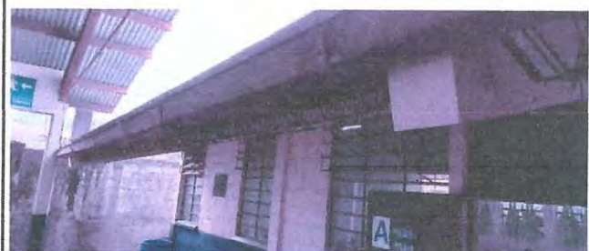
Foto 12: SUSTITUCIÓN DE CANALES
