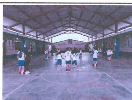
Foto 6: PINTURA INTERIOR ESCUELA
