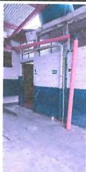
Foto 13: BAJADA Y CONEXIÓN A DRENAJE
