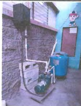
Foto 20: MATENIMIENTO DE BOMBA
