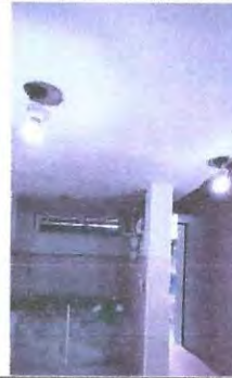
Foto 8: MEJORAMIENTO DE SISTEMA ELÉCTRICO COCINA
