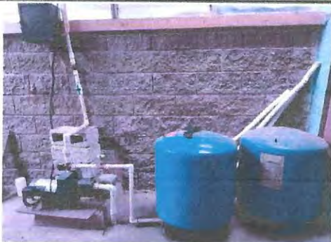
Foto 19: MATENIMIENTO DE BOMBA
