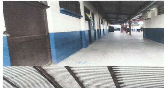
Foto 4: Aplicación de pintura en puertas del centro educativo.
