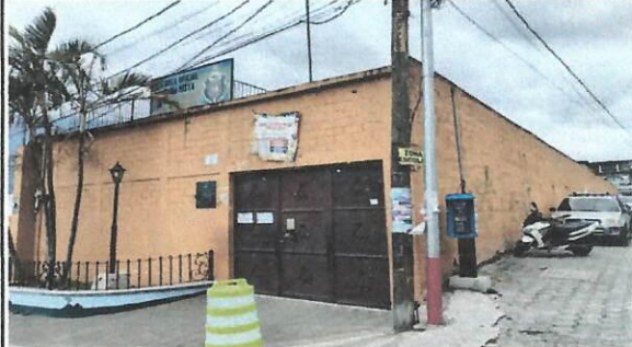
Foto 6: Aplicación de pintura frente y costado de la escuela principal y área del anexo.
