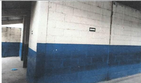
Foto 3: Aplicación de pintura en área de zocalo.
