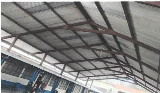
Foto 5: Mantenimiento y aplicación de pintura en costaneras del patio principal y salones de clase.
