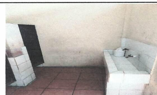
Foto 11: Sustitución de chorros por accesorios de lavamanos.
