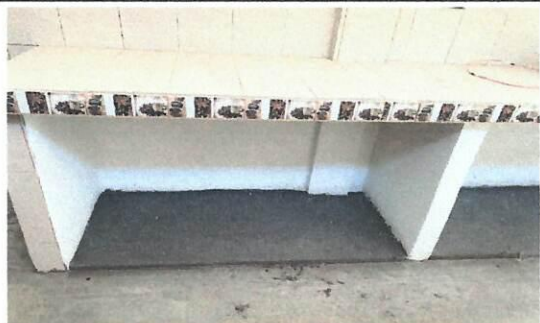
Foto 7: Elaboración de gabinete con entrepaño.
