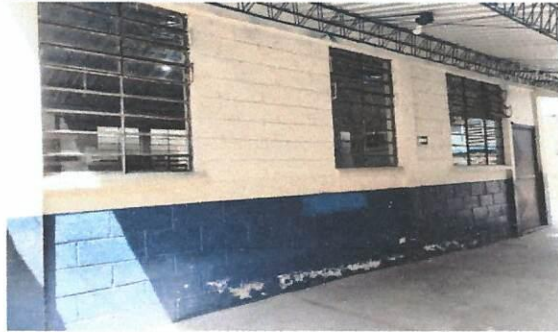
Foto 1: Aplicación de pintura en aulas de la escuela.
