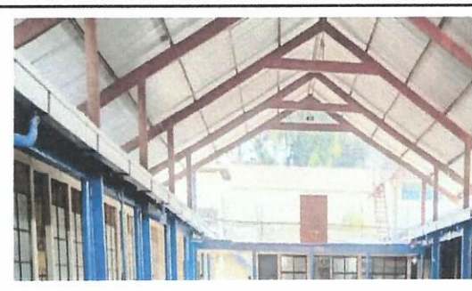
Foto 12: Fabricación e instalación de estructura metálica.
