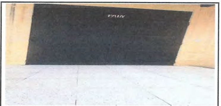
Foto 4: SUMINISTRO Y MANTENIMIENTO DE PORTÓN DE CEIN PAIN
