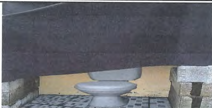
Foto 7: SUMINISTRO Y MEJORAMIENTO DE SANITARIOS DE CEIN PAIN CASERIO EL PORVENIR
