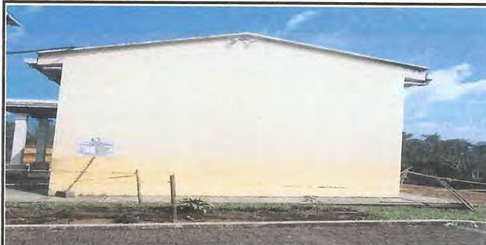
Foto 8: SUMINISTRO Y APLICACIÓN DE PINTURA A 200 MTS DE PARED A SALÓN DE CEIN PAIN
