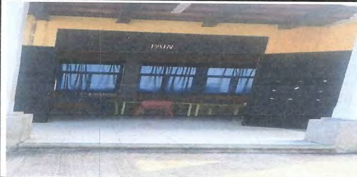
Foto 1: SUMINISTRO Y COLOCACIÓN DE 51 METROS DE PISO DE INTERIOR DE AULA DE CEIN PAIN CASERIO EL PORVENIR
