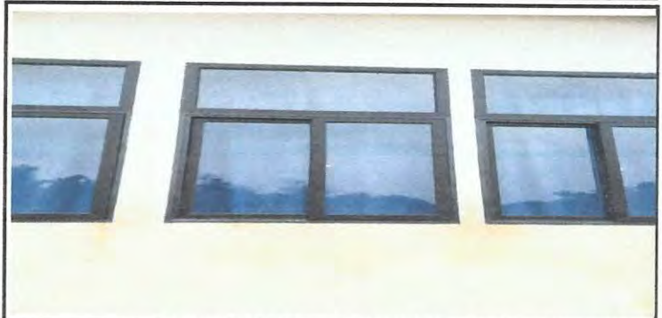
Foto 2: SUMINISTRO Y FABRICACIÓN DE 6 BALCONES DE 2.30 X 2MTS PARA SALÓN DE CEIN PAIN
