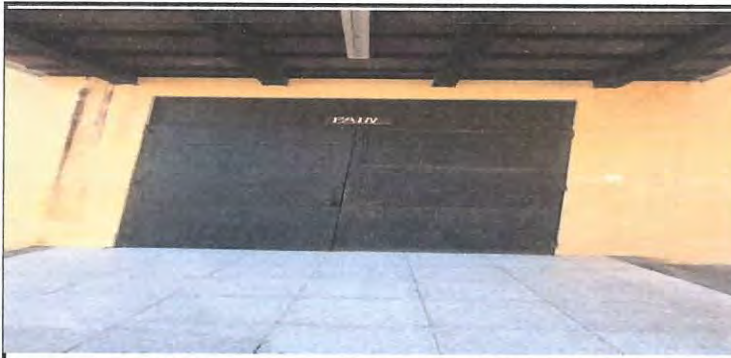
Foto 3: SUMINISTRO Y REPARACION DE TECHO POR FILTRACIONES DE SALÓN DE CEIN PAIN
