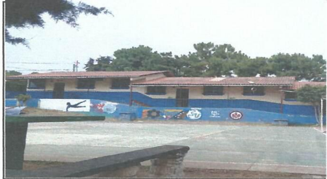
foto 2: se muestra parte del módulo 2 donde se hará cambio de canales
