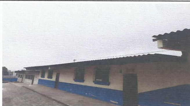
foto 7 : se muestra foto del módulo 1 donde no hay canales
