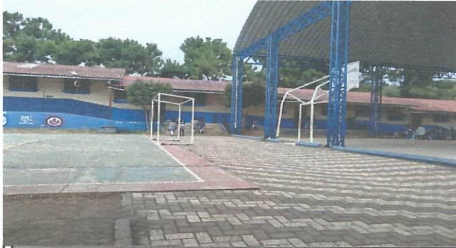
Foto 1: se muestra el espacio entre las 2 canchas donde se instalará el techado del encaminamiento
