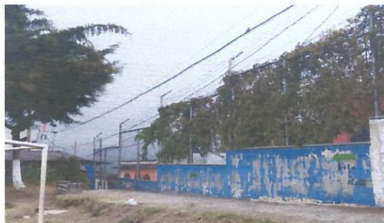
Foto 9: parte de la malla perimetral donde no hay techo.
