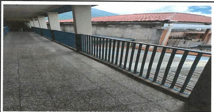
Foto 8: Mantenimiento y pintura de 125 metros de baranda de metal, ubicadas en graderíos y corredores. Pintura anticorrosiva azul.
