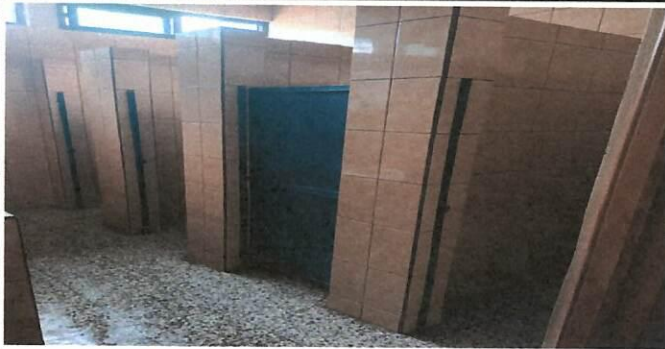
Foto7: Mantenimiento y pintura de 20 puertas de metal ubicadas en sanitarios del primer y segundo nivel. Pintura anticorrosiva color azul.
