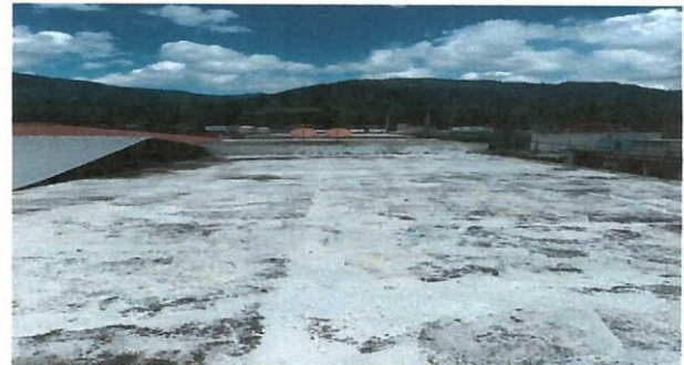
Foto 2: Limpieza, resanado, lavado e impermeabilización de 675 metros cuadrados de loza, en el segundo y tercer nivel. Impermeabilizante 7 años.
