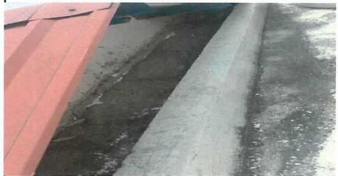
Foto 4: Limpieza, reparación e impermeabilización de canal de concreto en área de terraza del tercer nivel
