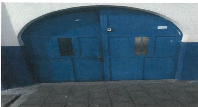
Foto 3: Mantenimiento y pintura de 3 portones de 2 bandas, en áreas de acceso al establecimiento.
