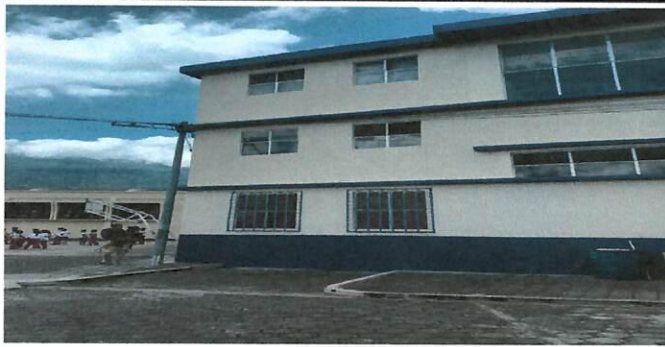
Foto 9: Instalación de 6 ventanas de pvc nogal oscuro, en parte exterior del edificio. En primer, segundo y tercer nivel.
