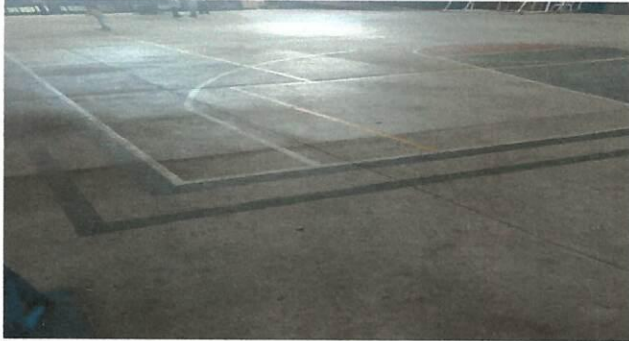
Foto 1: Limpieza, pintura y marcaje de la cancha ubicada en el interior del establecimiento, usando pintura de tráfico.
