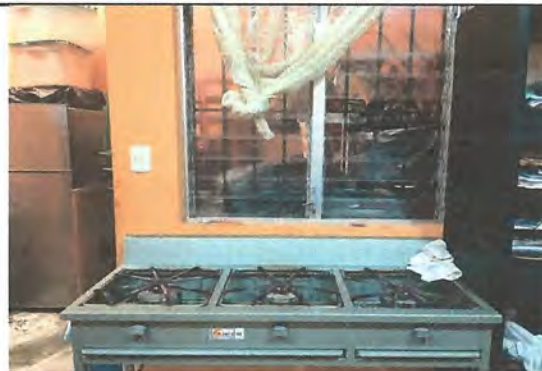
Foto2: Reparación de cocina
