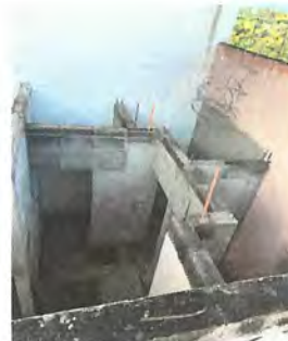
Foto 4: Techado de sanitarios y accesorios de sanitarios y cerca de muro perimetral
