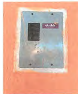
Foto 6: Reparación del sistema eléctrico.
