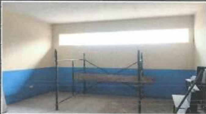
Foto 1: Ventanería a instalar
