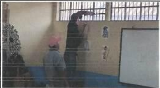
Foto 2: Ventanería que se cambiará
