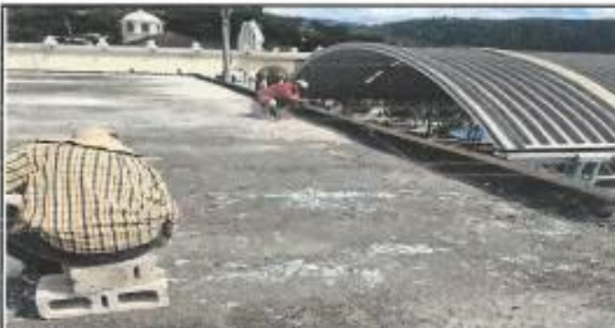
Foto 6: Se impermeabilizará la losa.
