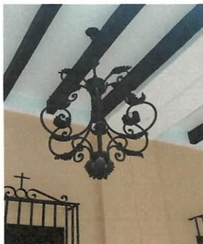
Foto 1: Limpieza de 17 Candelabros y colocación de 40 Bombilla Led clásica 15 w DL LUXLITE / 25 Plafoneros S-cadena 100w 125/250V. / Bombilla Led 20w MV DL ROSCA / instalación de Plafoneras
