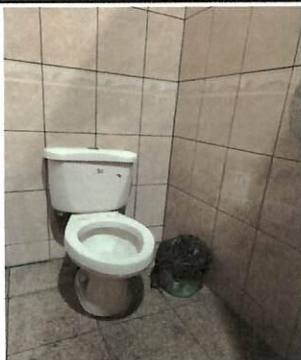
Foto 3: Sanitario de dos piezas con descarga DUAL AMERICAN STANDARD, contra llave a la pared 1/2 x 1/2 pulgadas, 1 tubo abasto flexible metálico para inodoro 3/8 x 1/2 x 20 INFLUIDMASTER
