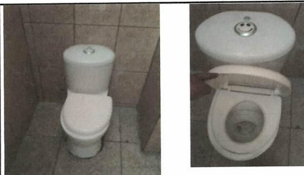
Foto 12: Reemplazo de un Mni baño en el primer Nivel
