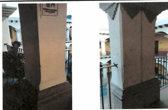
Foto 11: Mano de obra pintura en columnas
