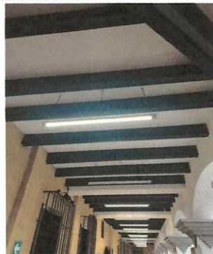
Foto 2: Instalación de Plafoneras y colocación de 25 focos.
