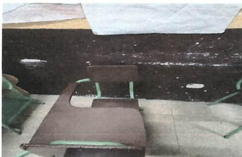
Foto 11: Pintura de interior
