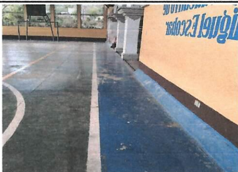
Foto 3: Pintura de cancha
