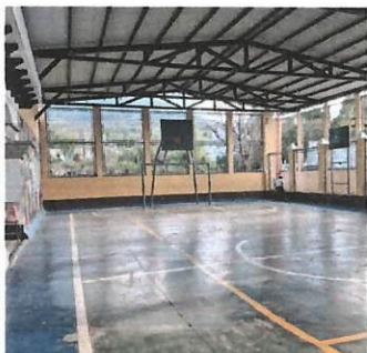
Foto1: Pintura de cancha
