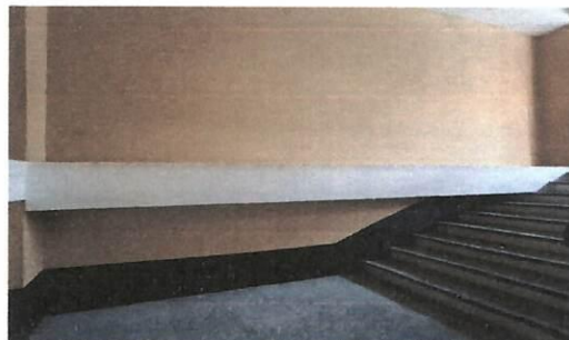
Foto 10: Pintura de columnas
