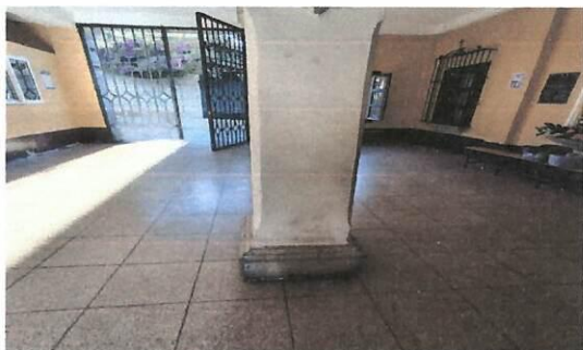
Foto 9: Pintura de columnas
