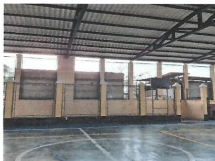
Foto 12: Pintura de interior escuela
