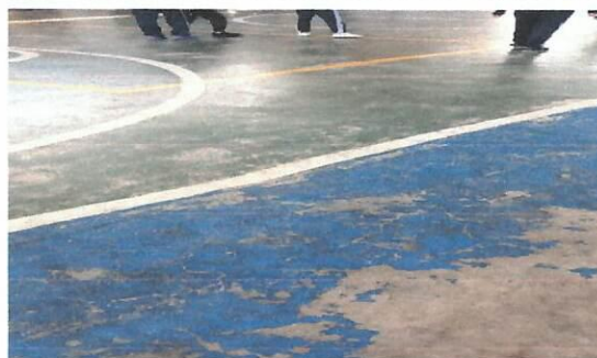
Foto 2: Pintura de cancha
