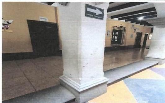
Foto 8: Pintura de columnas
