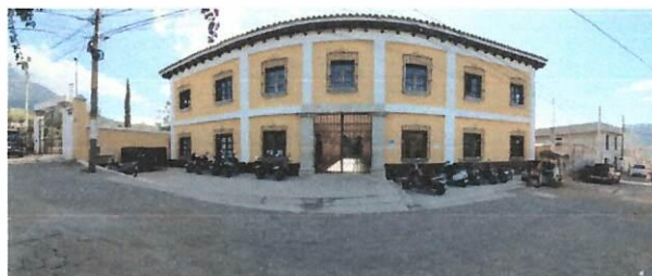
Foto 4: Pintura de exteriores
