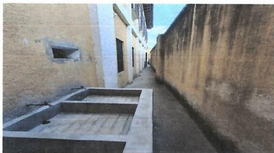
Foto 7: Pintura de exteriores
