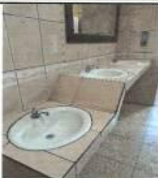
Foto 7: Cambio grifería de lavamanos
