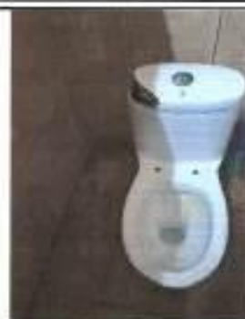
Foto 8: Remozamiento de servicios sanitarios
