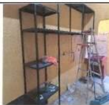
Foto 6: Remozamiento pared de cocina
