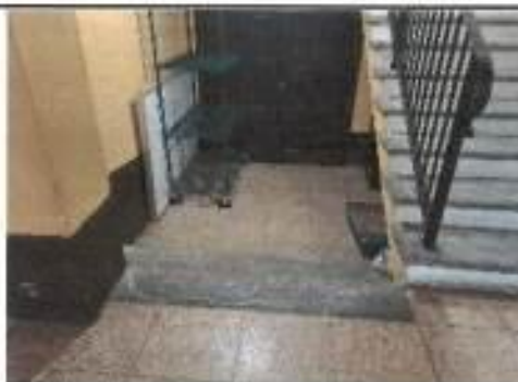
Foto 3: Colocación de baranda
