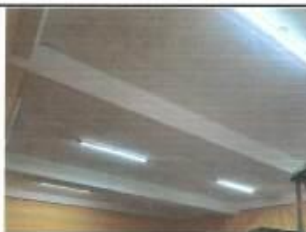
Foto 12: Cambio luminarias aulas
