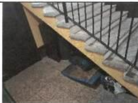
Foto 4: Remodelación rejas de gradas
