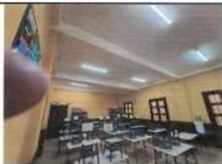
Foto 11: Cambio luminaria aulas
