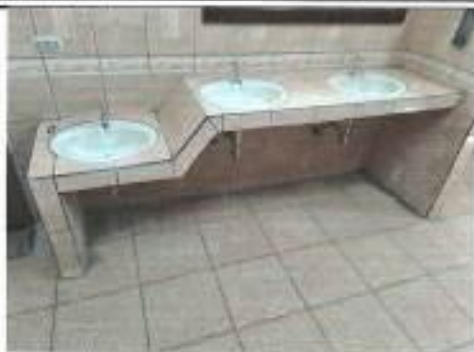
Foto 13: Colocación de gabinete en lavamanos de niños
