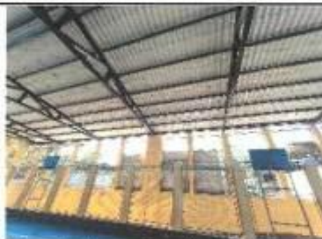
Foto 10: Remozamiento muro de cancha polideportiva
