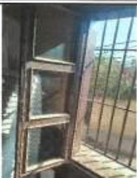
Foto 1: Remozamiento de ventanas
