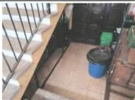
Foto 10: Colocación de baranda de seguridad.
