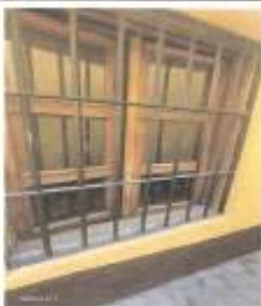
Foto 13: Mantenimiento de ventanas
