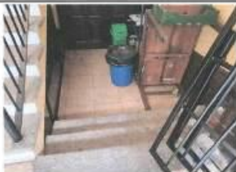
Foto 9: Colocación de rejas bajo las gradas
