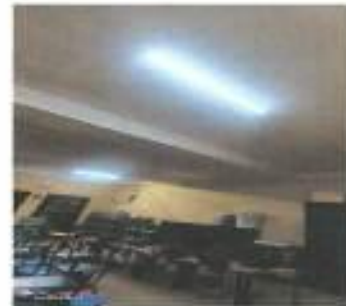
Foto 4: Cambio de iluminación Primer Nivel
