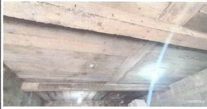
Foto 4: cernido de paredes, cielo raso e instalación de piso.
