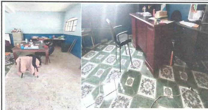
Foto1: Salón 1. cambio e instalación de piso.
