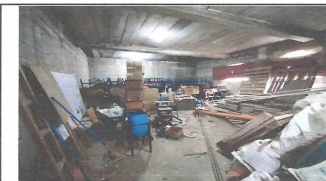
Foto 6: Salón 3. instalación de ventanas, cernido de paredes, cielo raso e instalación de piso.
