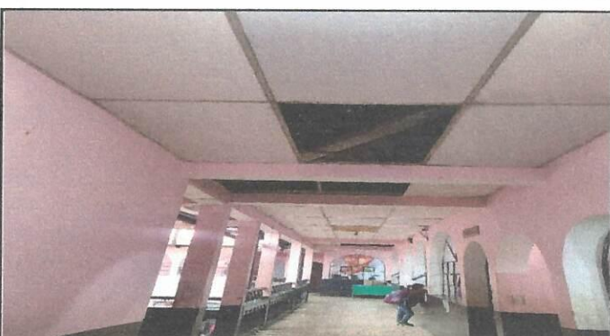
Foto 4: cielo falso y plafoneras en el corredor de la escuela
