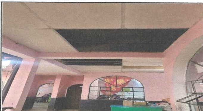
Foto 3: Cielo falso y plafoneras en el corredor de la escuela.
