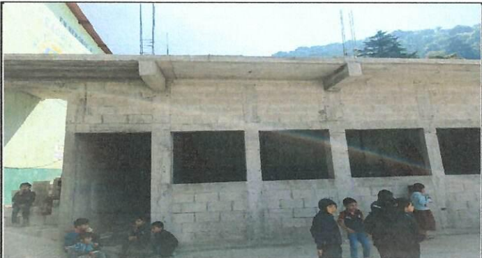
Foto 3: Colocación de Ventanas
