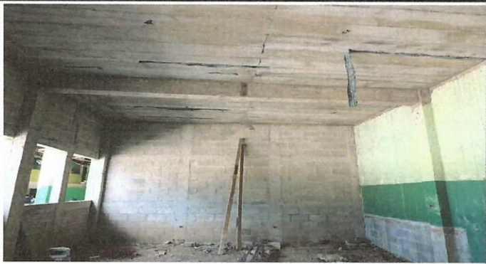
Foto1: Acabado del techo
