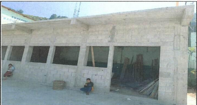
Foto 4: Colocación de puerta
