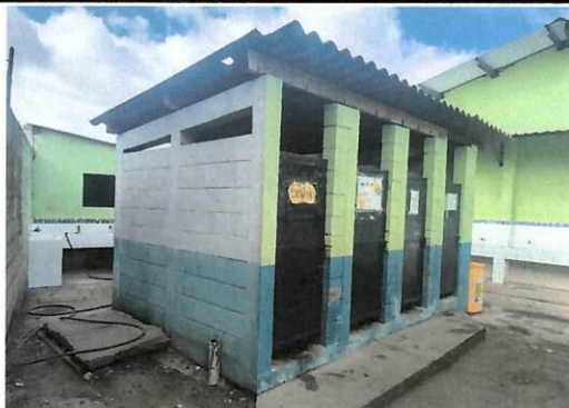
Foto 4: Estado actual del segundo módulo de sanitarios
