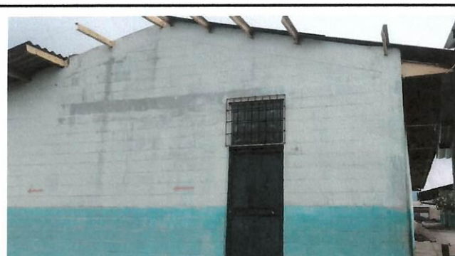
Foto 6: Estado actual del techo del lado Este
