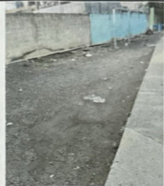
Foto 2: Estado actual del lado oeste del establecimiento
