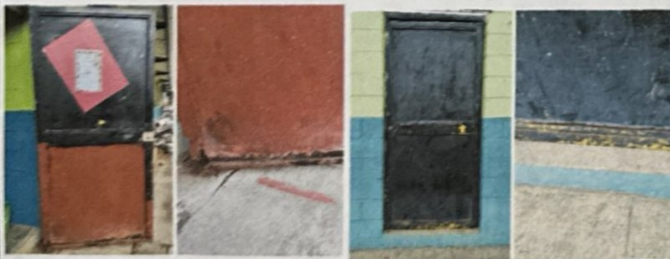
Foto 5: Estado actual de las puertas
