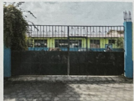
Foto 6: Estado actual del portón
