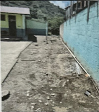
Foto 1: Estado actual del lado oeste del establecimiento
