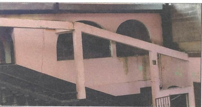
Foto 5: Fotografía en uno de los alrededores de la escuela.
