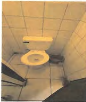
Foto13: CAMBIO DE BAÑOS DE NIÑAS
