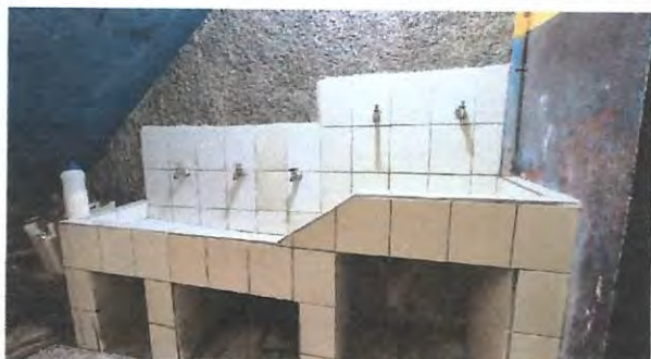
Foto 9: AMPLIACION DE LOS LAVAMANOS
