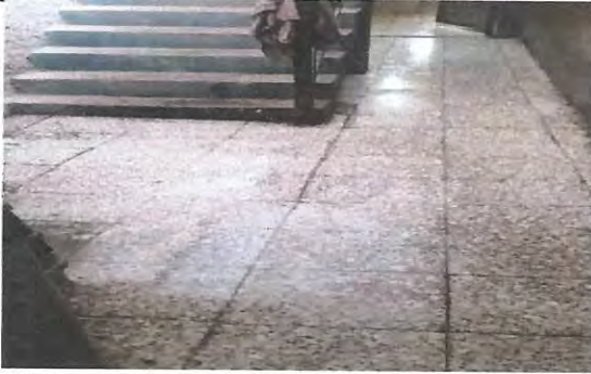
Foto 1: CAMBIO DE PISO EN EL PASILLO DE BAÑOS
