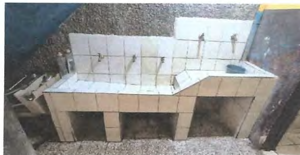
Foto 10: COLOCACION DE MAS CHORROS PARA LAVAMANOS
