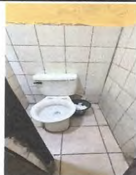
Foto 14: CAMBIO DE BAÑOS DE NIÑAS
