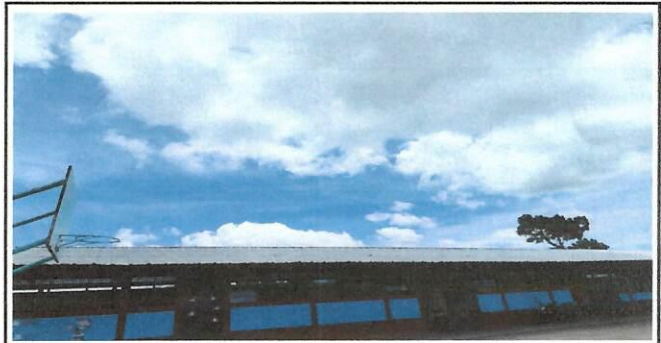
Foto 4: esquina pegada ala cocina
