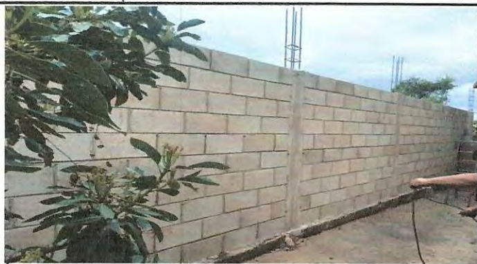
Foto 2: Levantamiento de paredes de muro perimetral al 100%
