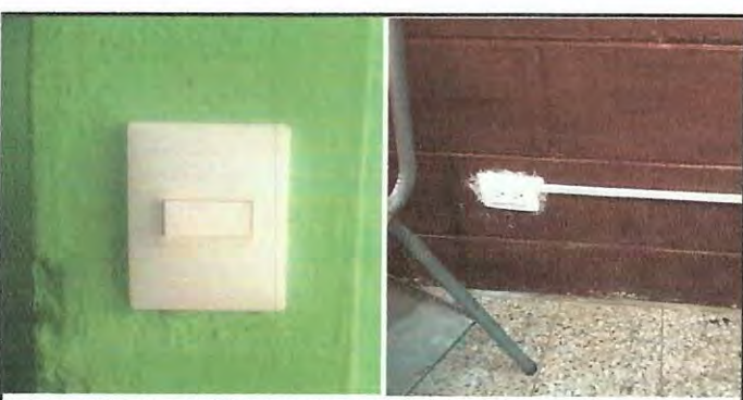
Foto 6: Instalación y cambio de tomacorrientes e interruptores switch
