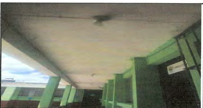
Foto 5: Cambio de cableado eléctrico y plafoneras de iluminarias existentes en corredores
