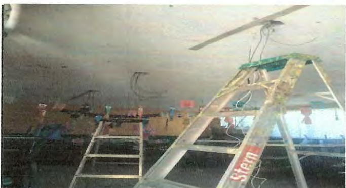
Foto 4: Cambio completo de cableado eléctrico de todos los salones de clase, corredores y sanitarios de luminarias existentes.
