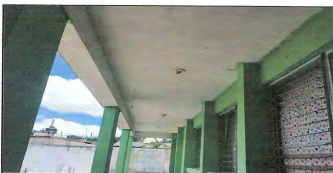
Foto 5: Mejoramiento de iluminarias en pasillos
