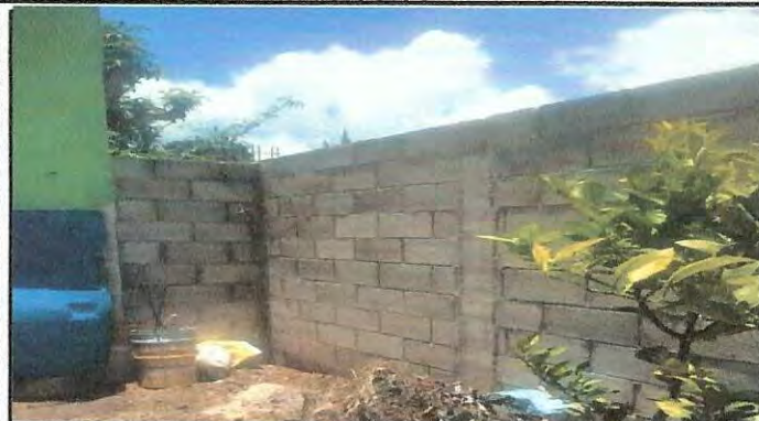
Foto 1: Construcción de cimiento y levantamiento de paredes de muro perimetral en área faltante 100%
