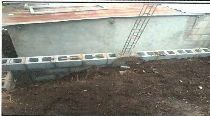
Foto 1: Ampliación de muro perimetral en área faltante
