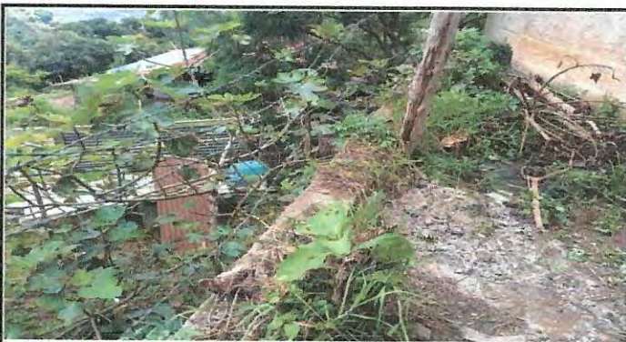
Foto 3: Ampliación de paredes del muro perimetral existente
