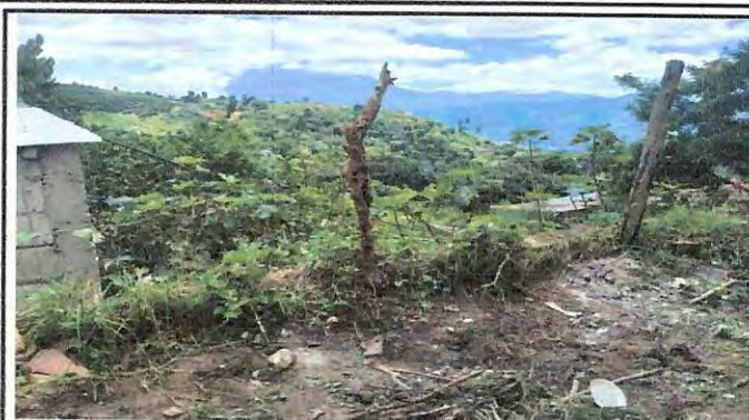
Foto 2: Ampliación de muro perimetral existente
