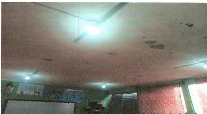
Foto 4: Cambio de iluminación, cableado y plafoneras en todos los salones de clases al 100%
