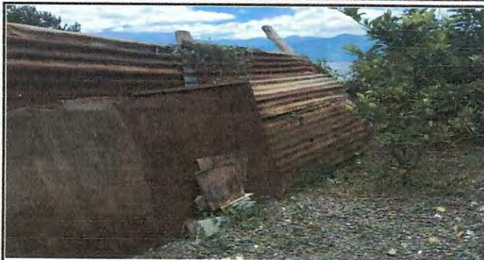
Foto 1: Mejoramiento de muro perimetral
