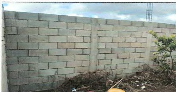
Foto 3: Levantamiento de pared en muro perimetral faltante al 100%
