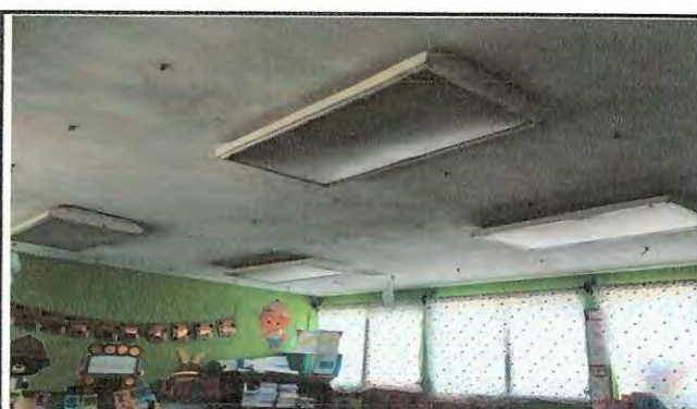
Foto 4: Mejoramiento de iluminarias en salones de clases
