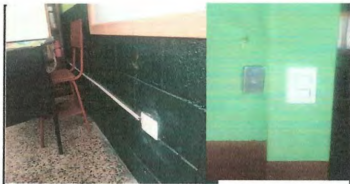
Foto 6: Instalación y cambio de tomacorrientes e interruptores switch existentes
