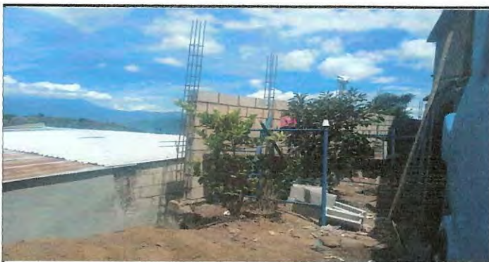
Foto 3: Levantamiento de pared de muro perimetral
