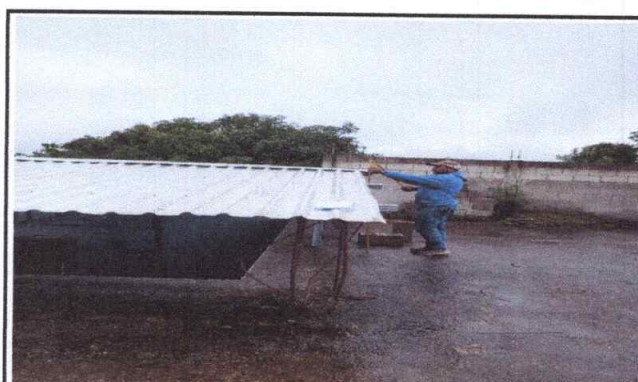
Foto de las medidas que se reforzarán para la iluminación del techo.
