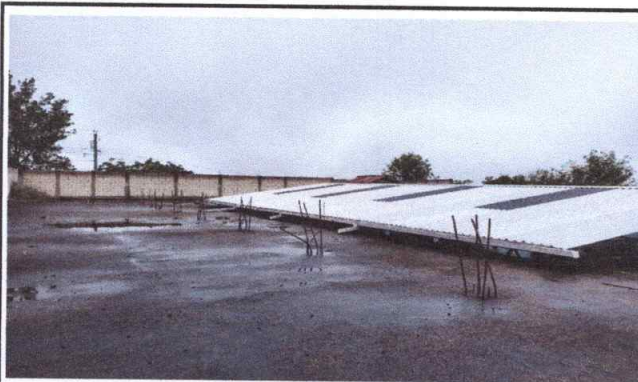
Acá se muestra la instalación del techo donde se quiere realizar, las bajadas del agua pluvial hacia la calle.
