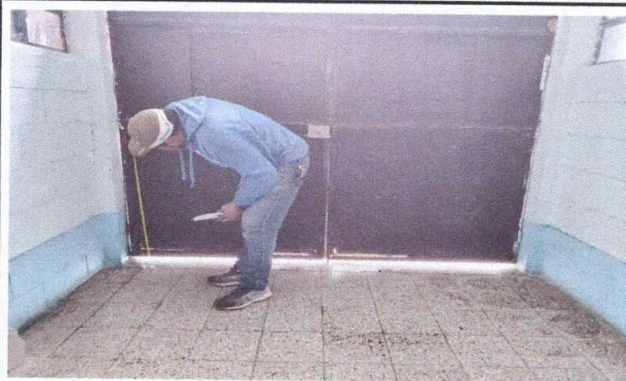
En esta primera fase, se inicia con las medidas del portón principal, para si cambio.
