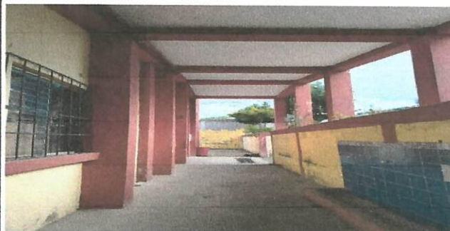
PINTURA DE COLUMNAS Y PAREDES DE PASILLOS EXTERIORES
