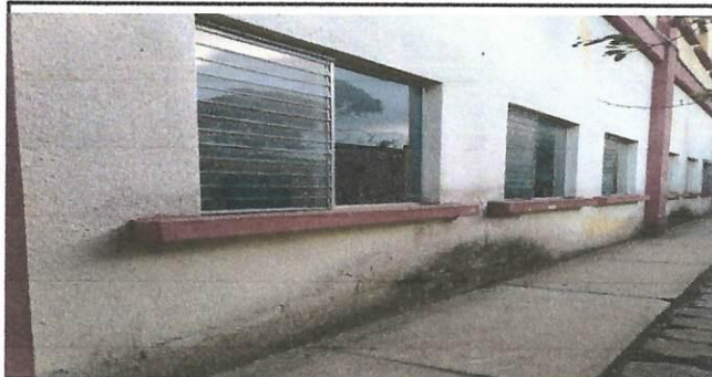
PINTURA A LOS COSTADOS DE LA ESCUELA
