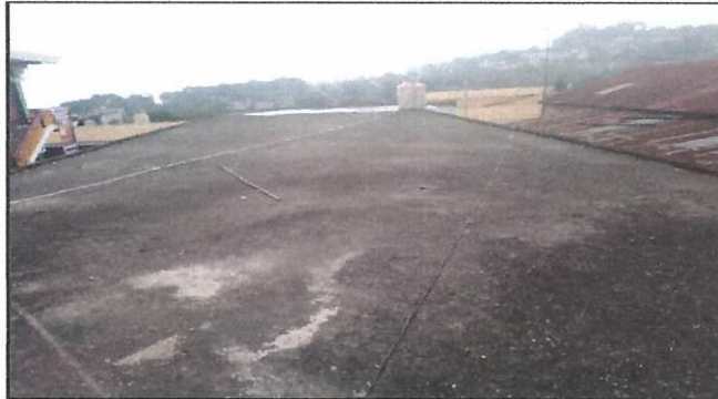
Foto 1: Impermabilización de terraza 250 m2
