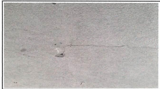
Foto 2: Reparación de cielos en aulas 160 m2
