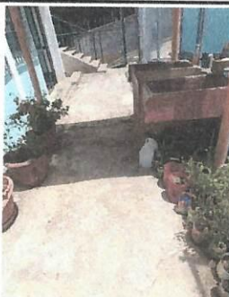
Foto 11 : Se realizará techado metálico de area de lavanderia
