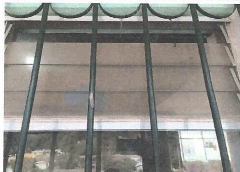
Foto 2: Se realizarán las sustituciones de paletas de vidrios de persianas de los ventanales del establecimiento
