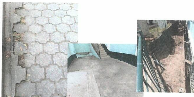
Foto 7: Losa de patio. Se fundiran tres espacios en el primer y segundo nivel
