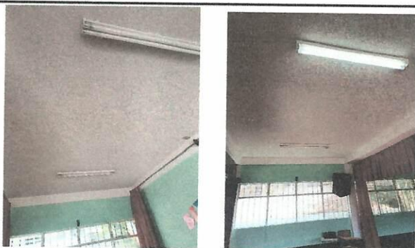
Foto 9: Se reparará sistema electrico, gasneones por focos ahorradores y cambio de interruptores y tomacorrientes
