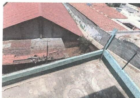
Foto 12: se pintarán las paredes del area de muro perimetral
