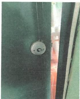
Foto1: Se harán las reparaciones correspondientes de las puertas
