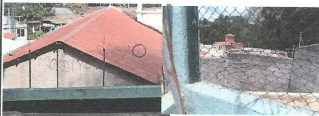
Foto 10: Se realizará la reparaciòn de malla perimetral del establecimiento.
