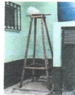
Foto 10: CAMBIO DE PUERTA DE INGRESO AL TANQUE DE AGUA, COLOCACION DE REJA
