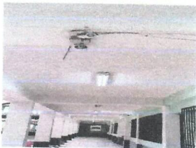
Foto 11: REPARACION DE CAMARAS
