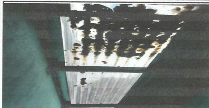
Foto 1: Losa sobre bodega y piso.
