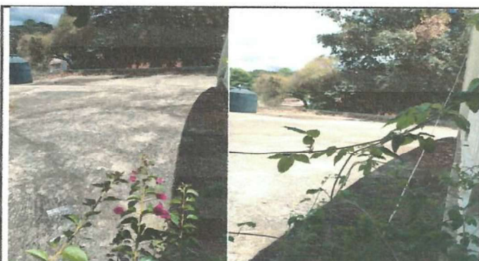
Foto 4: Mantenimiento, limpieza e impermeabilización de la losa de la azotea.
