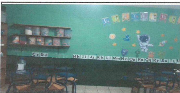
Foto 5: Impermeabilización de un muro de un aula.
