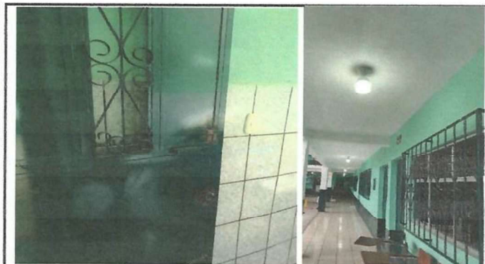
Foto 3: Mantenimiento de puertas, regías para proteger los focos.
