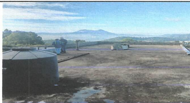
Foto 6: area de terraza que necesita limpieza e impermeabilizada.
