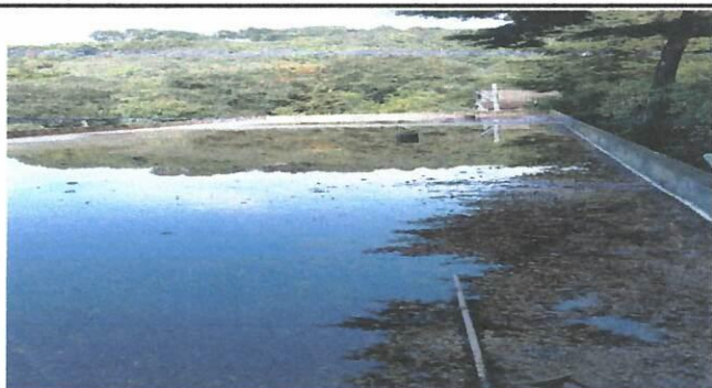
Foto 5: area de la terraza que necesita limpieza y ser impermeabilizada
